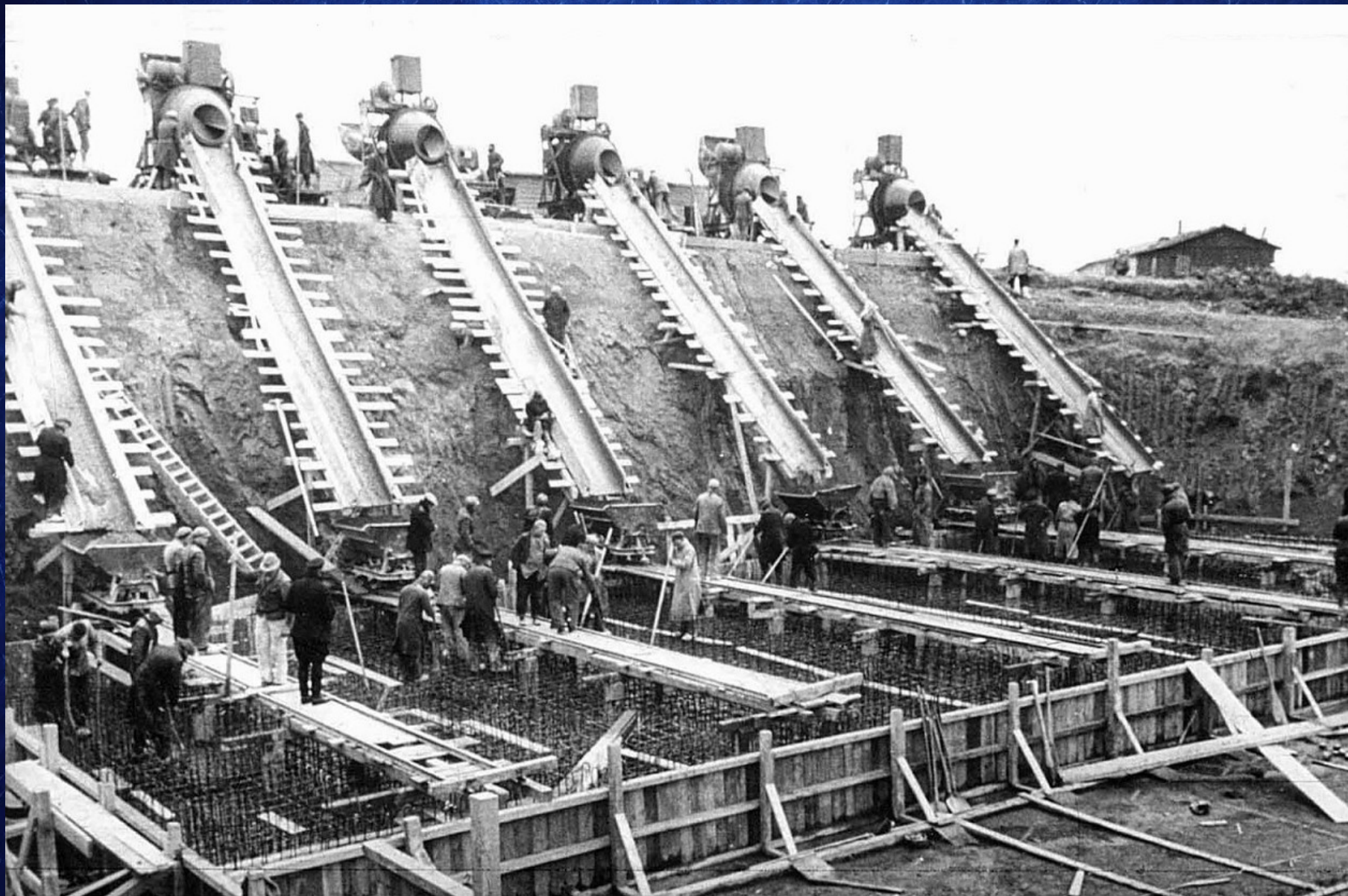
Travailleurs affectés à la construction d'une casemate de batterie Todd près de Calais dans le cadre de l'édification du mur de l'Atlantique
