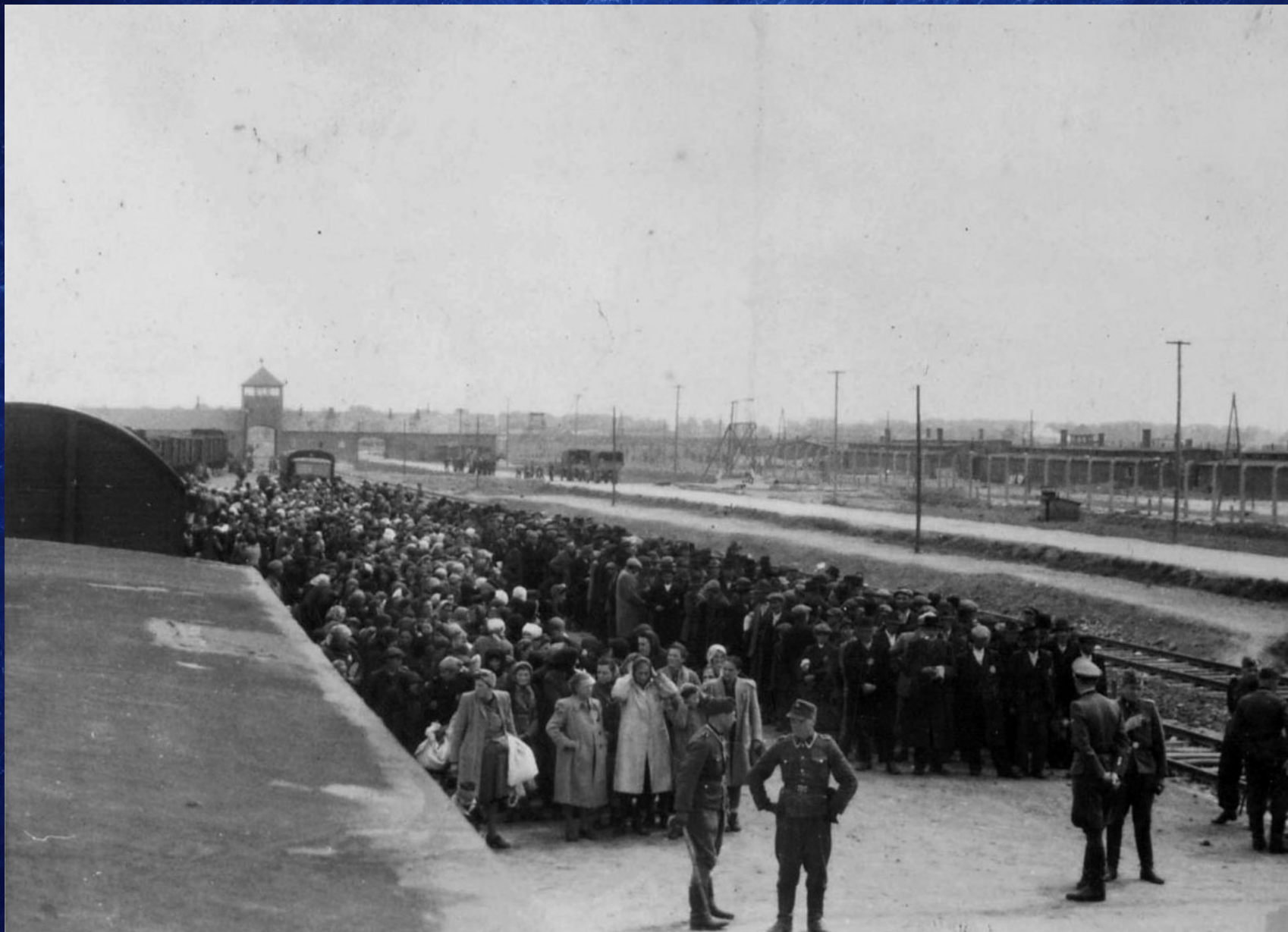
Les deux colonnes sont constituées Au fond de l'image, la sinistre porte d'entrée du camp d'Auschwitz
