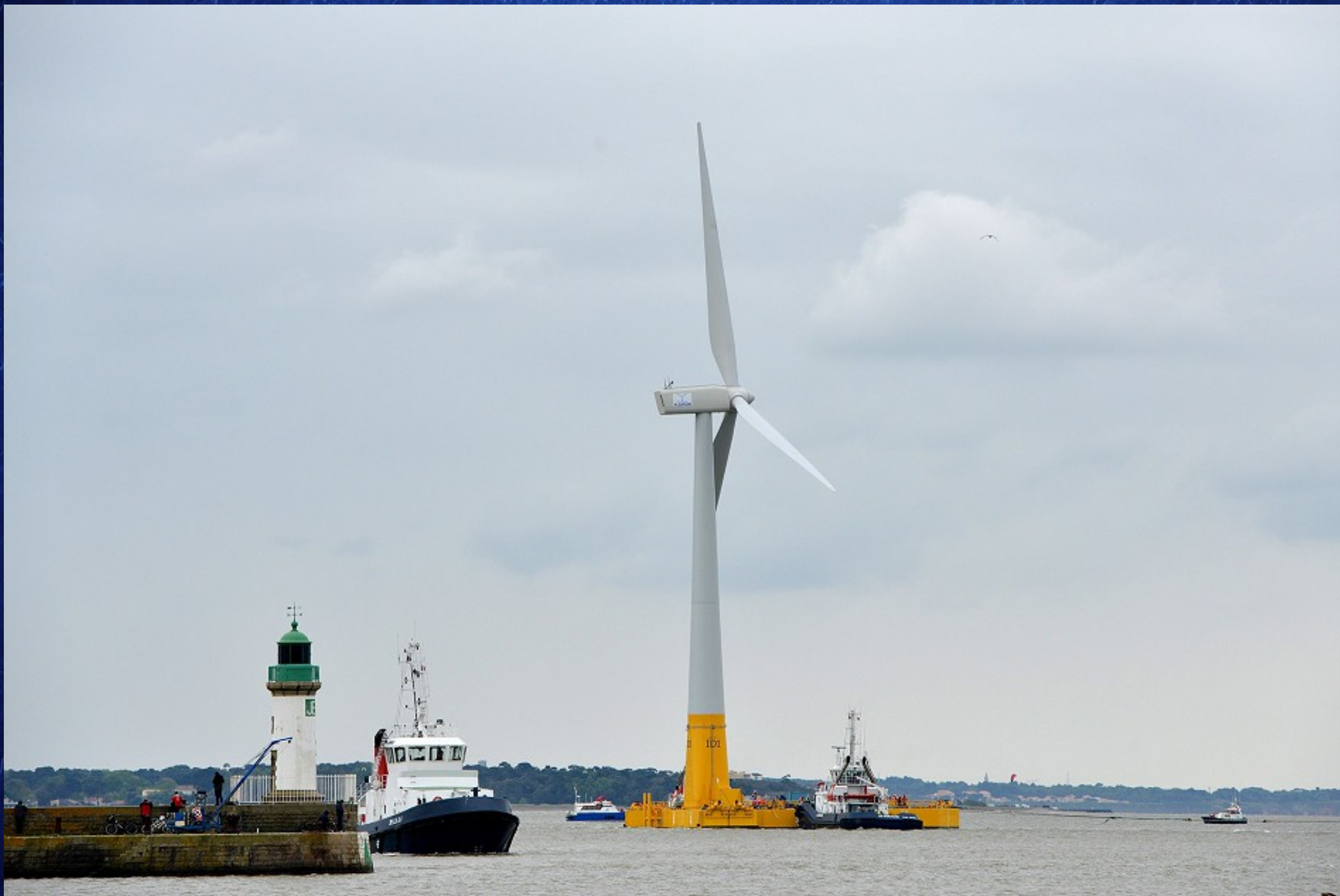
Floatgen, la première éolienne flottante marine française, au large du Croisic Un premier parc de 80 éoliennes devrait voir le jour sur le banc de Guérande en 2021
