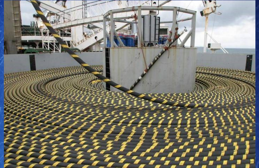
Bobine de câble sur un navire câblé
