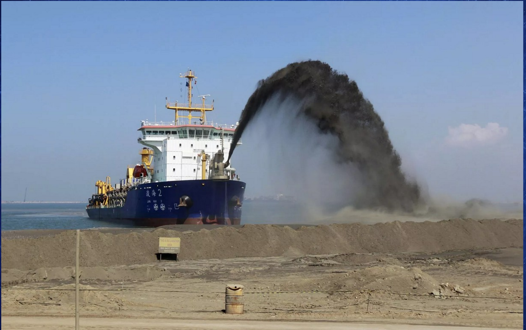
Extraction de sable et de granulats au Sri Lanka par une drague
