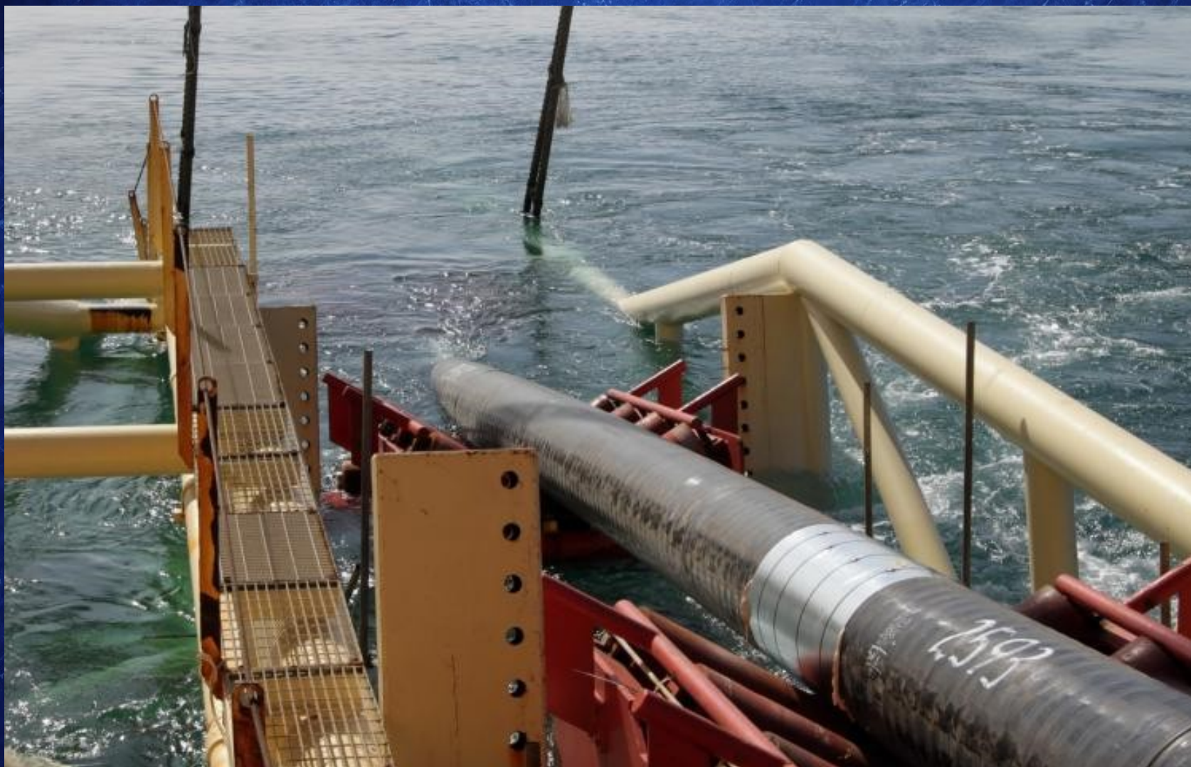
Gazoduc sous-marin de la société russe Gazprom
