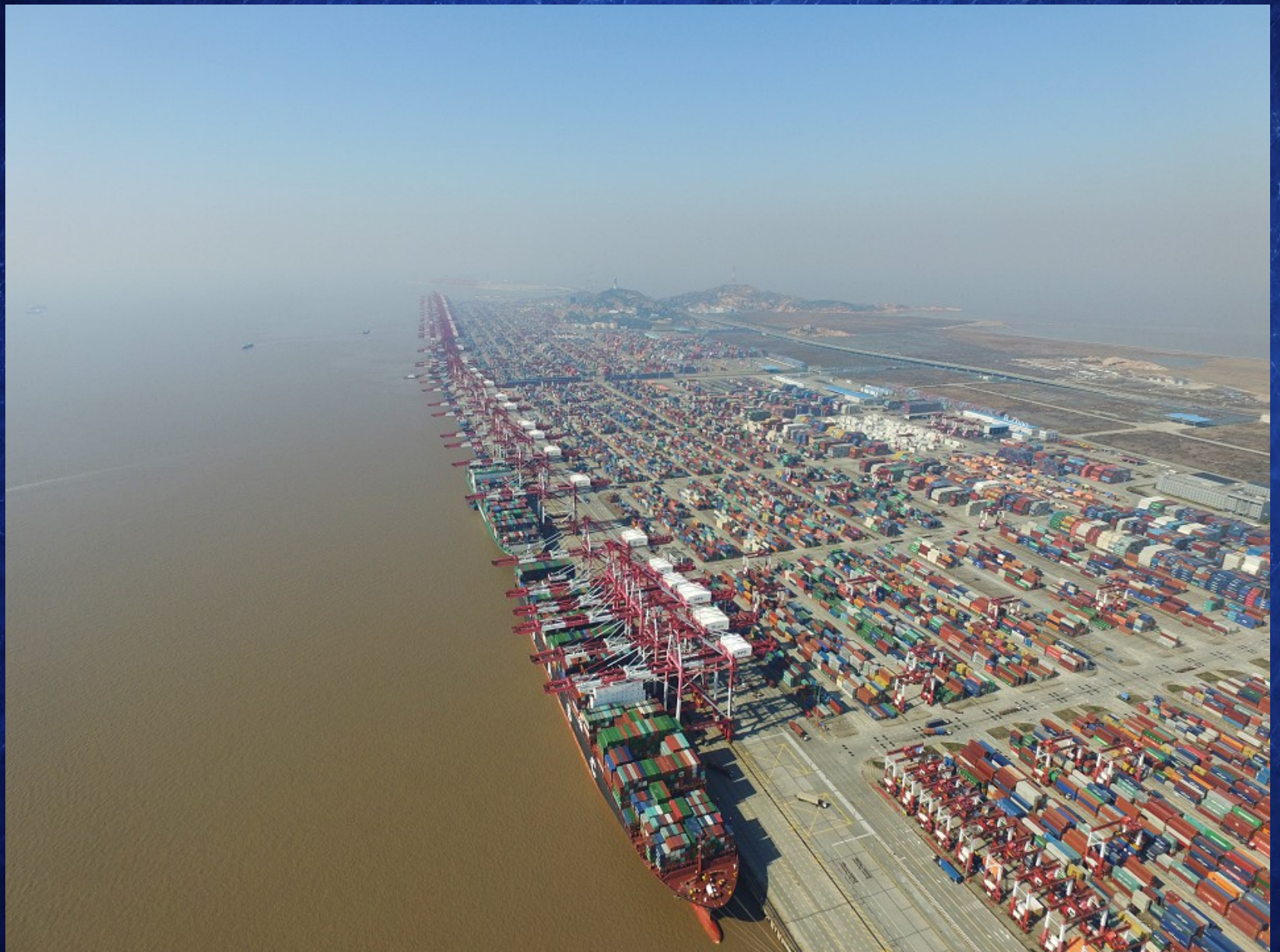
Vue d'ensemble d'une partie du port de Yangshan à Shanghai
